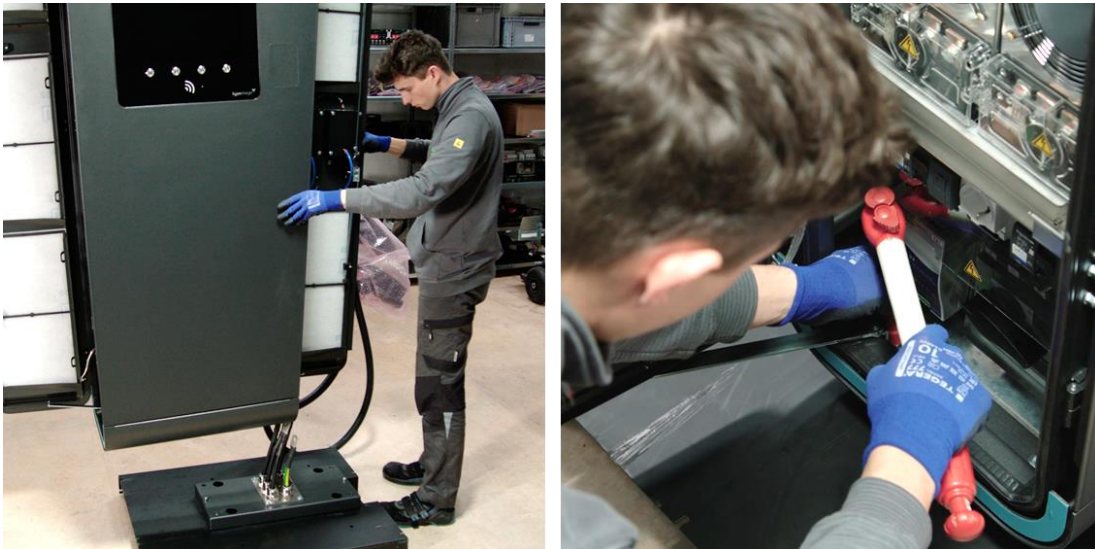
Abbildung 48: Positionierung HYC400 auf Sockel und Befestigung
